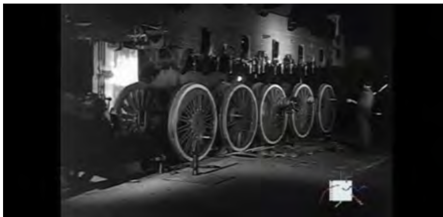
Figura 7. Fotogramma riguardante la posa del telaio sulle ruote di una locomotiva a vapore Breda.
