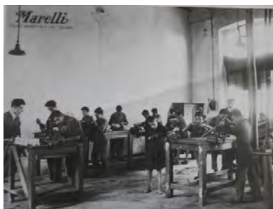
Figura 6. Apprendisti al lavoro nello stabilimento Marelli
